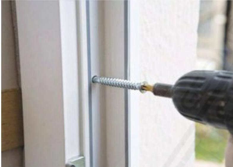
Fissare alla struttura tramite viti AMO III
